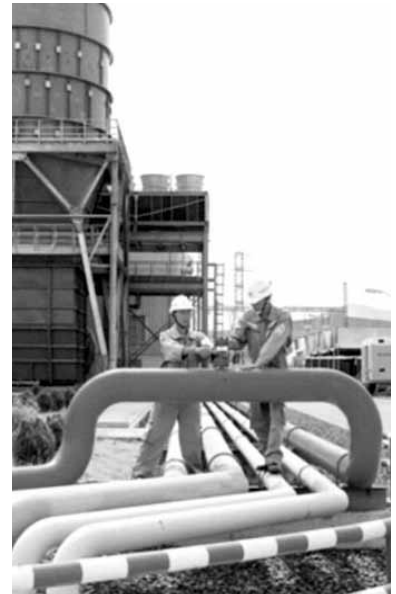
Kiểm tra an toàn đường ống dẫn dầu - Ảnh BP
