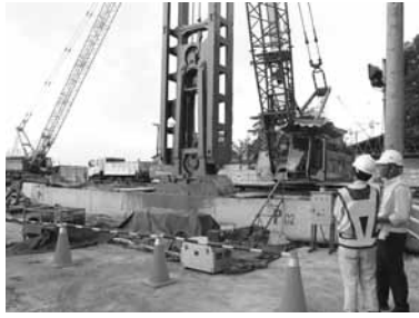
Kiểm tra an toàn vận hành cầu tháp tại một công trình xây dựng - Ảnh Việt Dũng
