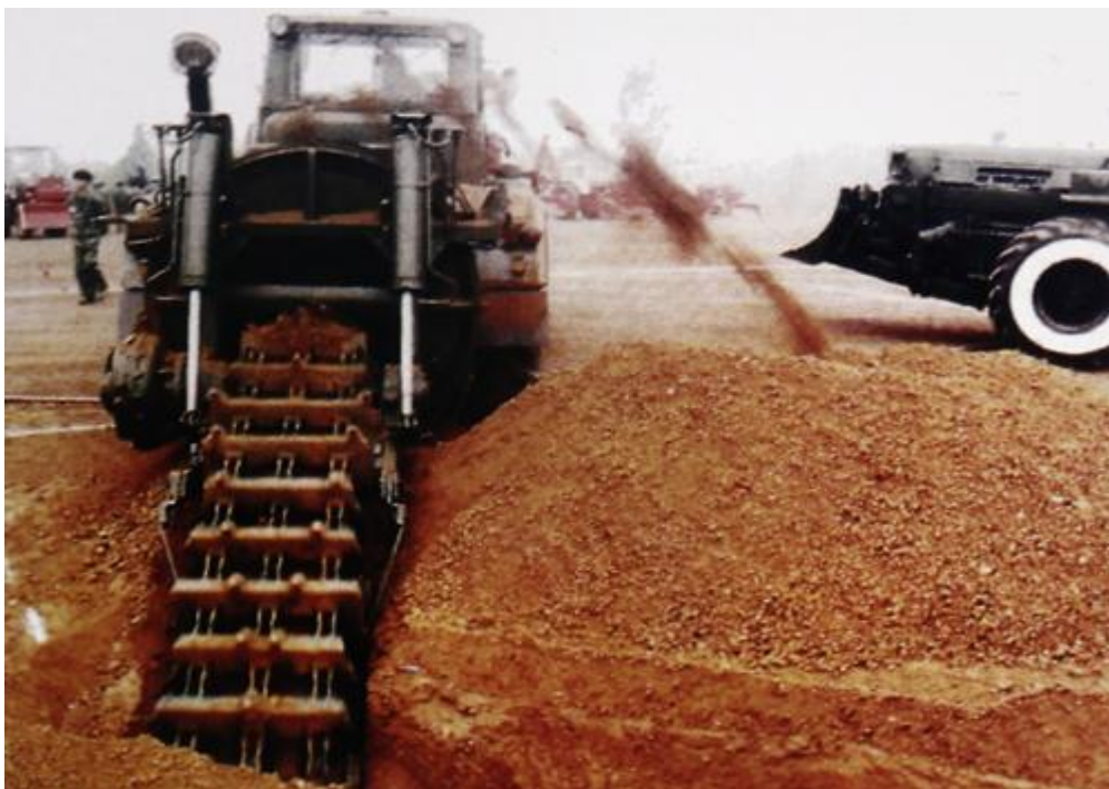
Huấn luyện kỹ thuật sử dụng xe máy đào công sự.
