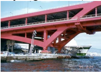
Hình 1.11 Cầu Kobe và hư hỏng móng do hóa lỏng đất [33]
