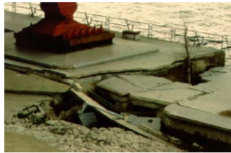
Hình 1.11 Cầu Kobe và hư hỏng móng do hóa lỏng đất [33]
